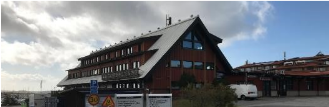
Befintlig verksamhetsbyggnad inom fastigheten.
